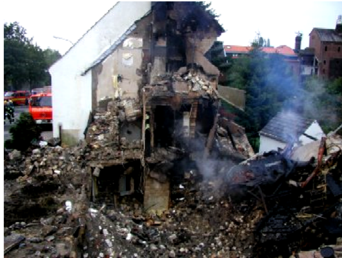
Abbildung: Haus nach einer Gasexplosion
